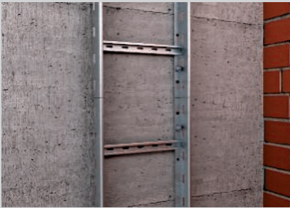
Direkte Montage der Steigeleiter LG an der Massivwand.
