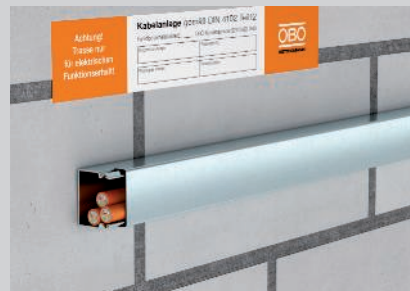
Saubere Verlegung von Daten- und Brandmeldekabeln im Kanal Typ 20030.
