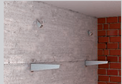
Montage der Ausleger und der schrägen Anschlussbauteile an der Wand.
