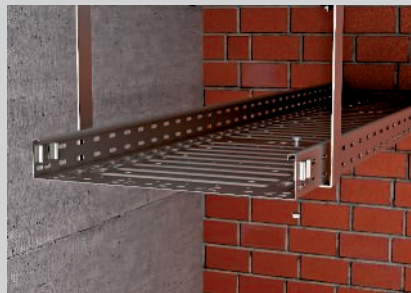
Befestigung der Kabelrinne mit Flachrundschaublen.
