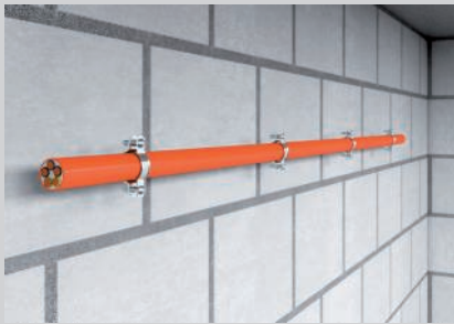
Waagerechte Montage der Kabel an der Wand.
