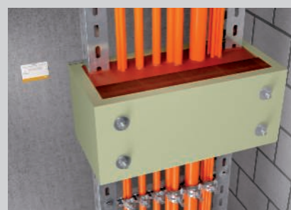
Fertig gefüllte Zugentlastung.
