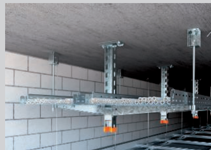
Zweilagige Deckenabhängung mit beidseitiger Auslegeranordnung.
