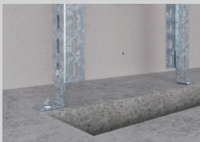
Auf dem Boden montierte Winkel zur Lagesicherung der Leiterholme.
