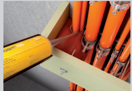
Befüllen des kompletten Gehäuses mit Brandschutzschaum PYROSIT® NG bei hoher Kabelbelegung.
