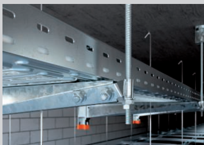
Montage der Gewindestangensicherung durch Anschlussbauteil an der Auslegerspitze.
