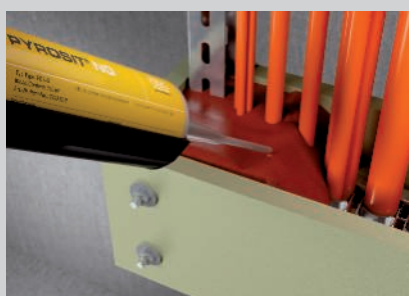
Auffüllen der Kabelzwischenräume mit Brandschutzschaum PYROSIT® NG.
