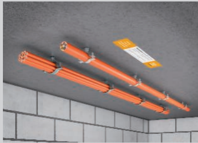
Montage unter der Decke.
