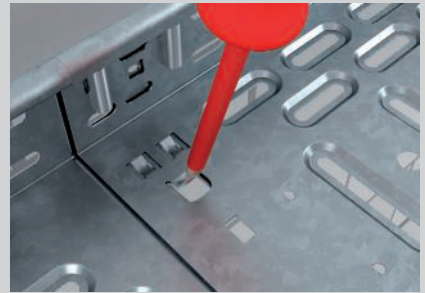
Umbiegen der Sicherungslaschen im Boden.
