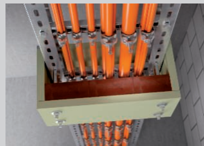
Befüllen des montierten Gehäuses mit Schaumstoffblöcken PYROPLUG® Block.
