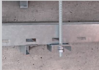
Befestigung der senkrechten Gewindestange am Anschlussbauteil.
