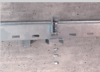
Montage des Anschlussbauteils schräg mit Sechskantschraube und Sechskantmuttern.
