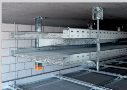
Zweilagige Deckenabhängung mit einseitiger Auslegeranordnung.
