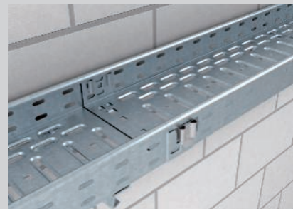
Fertige schraubenlose Stoßstellenverbindung.
