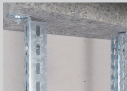
Deckenbefestigung der Leiterholme mit angeschraubten Montagewinkeln.
