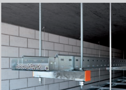
Einlagige Deckenmontage auf Montageschiene.
