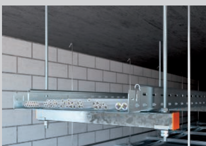
Einlagige Deckenmontage auf Montageschiene.
