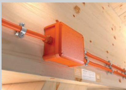
Montage der OBO FireBox am Holzbalken.
