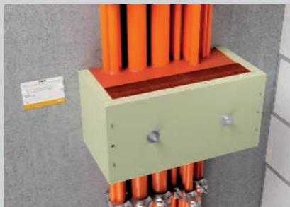
Fertig gefüllte Zugentlastung.
