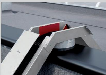
Montage des Kanaldeckels nach der Kabelverlegung.
