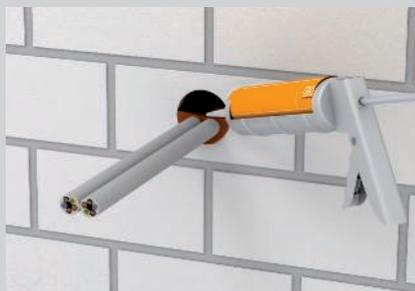
Verschließen der Öffnung mit der Spachtelmasse FBA-SP.
