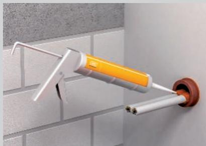
In leichten Trennwänden Einsatz der Minirohrschale FBA-DR.
