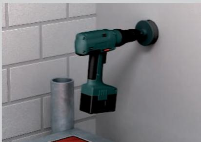
Bohren eines Lochs mit einem Dosenbohrer.
