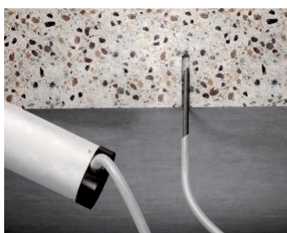
Ausblasen des Bohrlochs Decke Entfernen des Bohrmehls aus dem Bohrloch durch mehrfaches Ausblasen.
