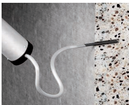
Ausblasen des Bohrlochs Entfernen des Bohrmehls aus dem Bohrloch durch mehrfaches Ausblasen.
