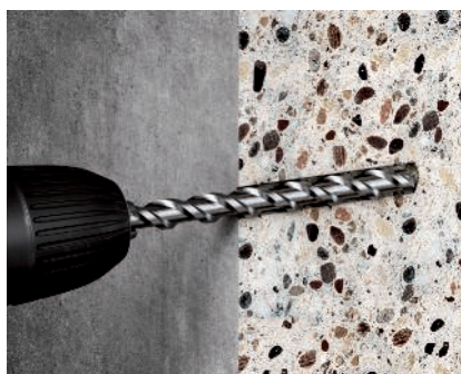
Dübelloch bohren Bohren des Dübellochs entsprechend den Angaben der Dübelzulassung zum Bohrlochdurchmesser und zur Bohrlochtiefe.
