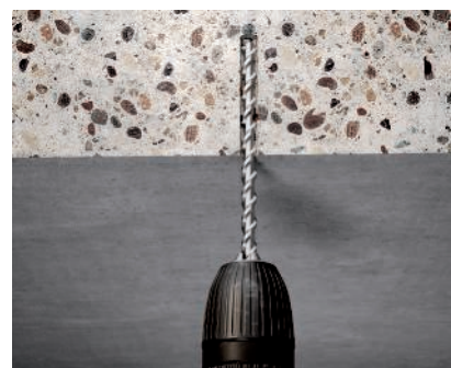
Dübelloch bohren Decke Bohren des Dübellochs in der Decke entsprechend den Angaben der Dübelzulassung zum Bohrlochdurchmesser und zur Bohrlochtiefe.
