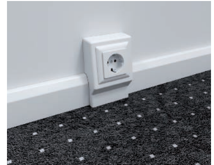
Fertig montierter Geräteträger.
